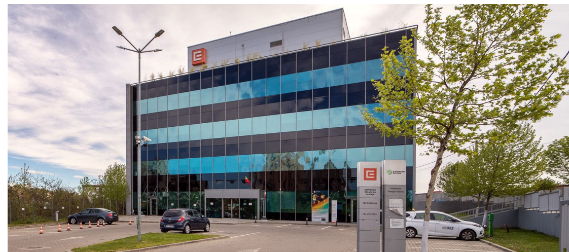
Obr. č. 3: Exteriér předmětné administrativní budovy ve městě Pitești a její nejbližší okolí. Zdroj: prezentace investora
