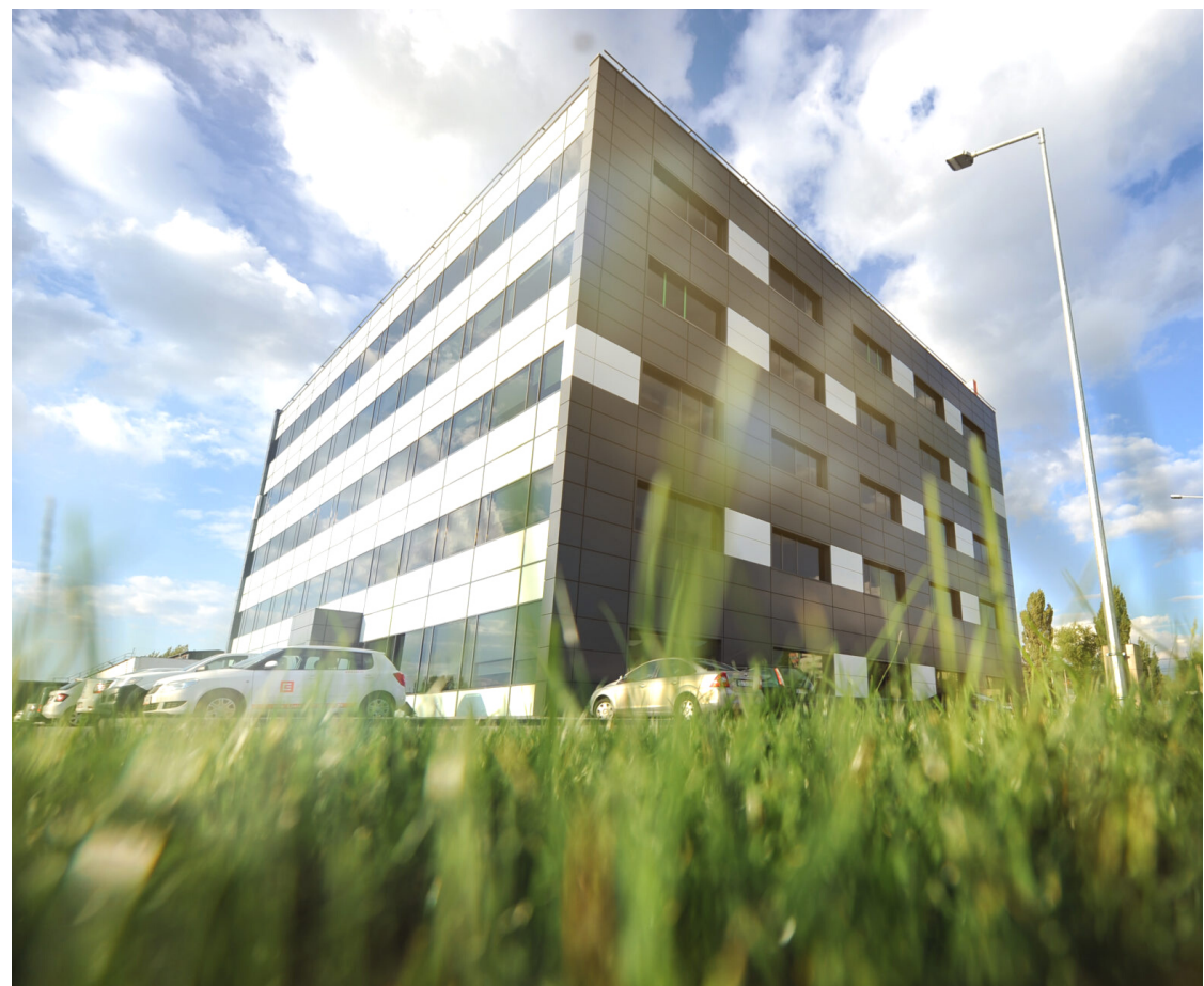
Obr. č. 1: foto předmětné budovy
